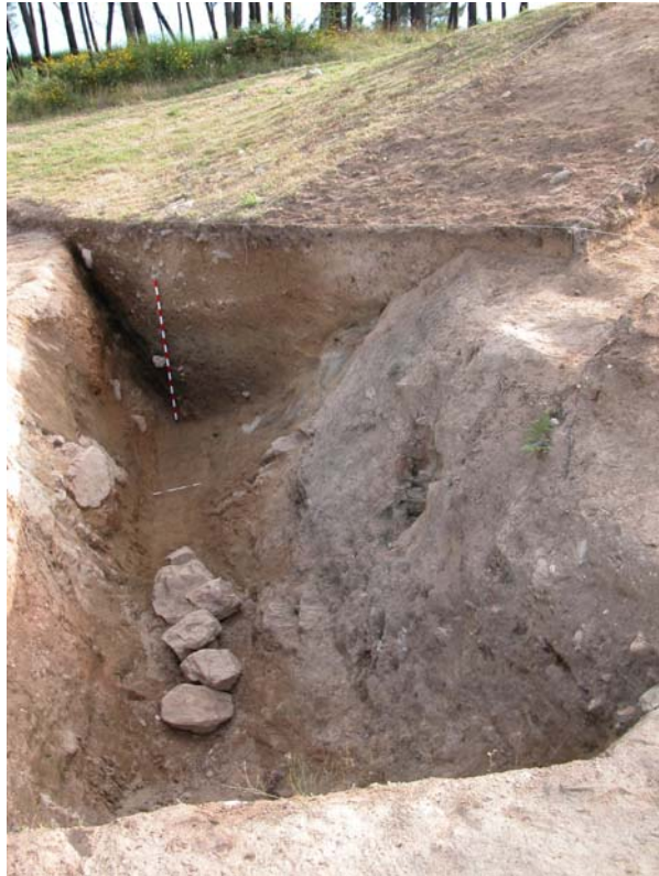
Figura 22. Escavación do novo tramo de foxo.
